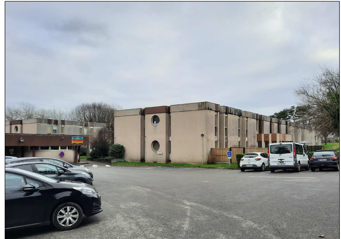
HEBERGEMENT AR MOR
